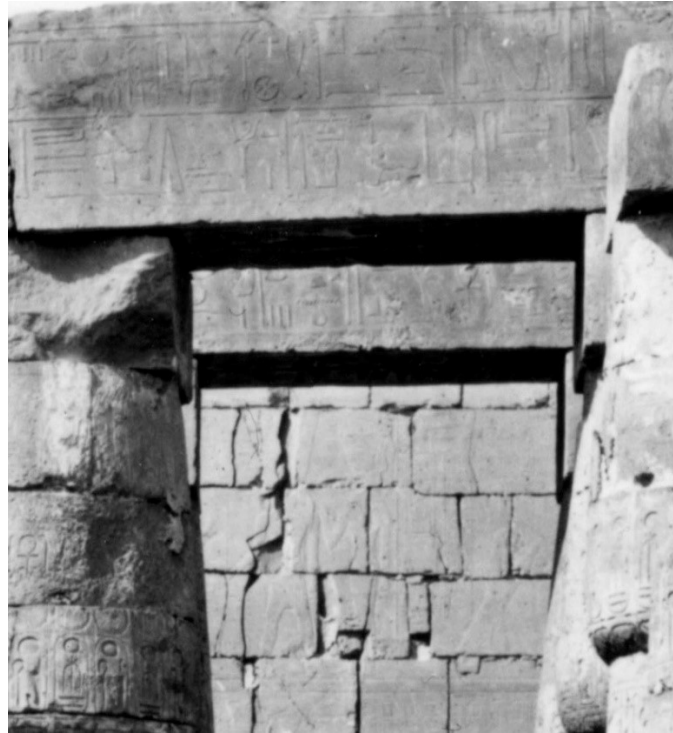
Figure 9: Détail de l'arrière-plan du cliché n° 80 de Béchard montrant le II e pylône et les architraves dans la partie ouest de la salle
